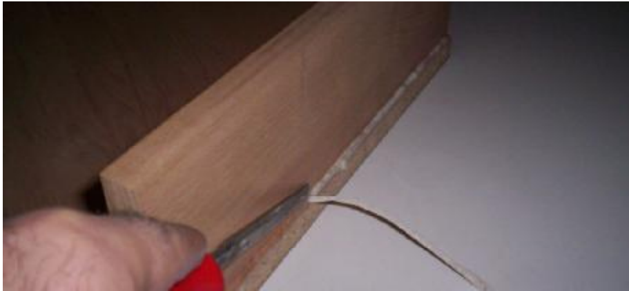
Resim 1.3: Poliüretan esaslı yapıştırıcının silinmesi
